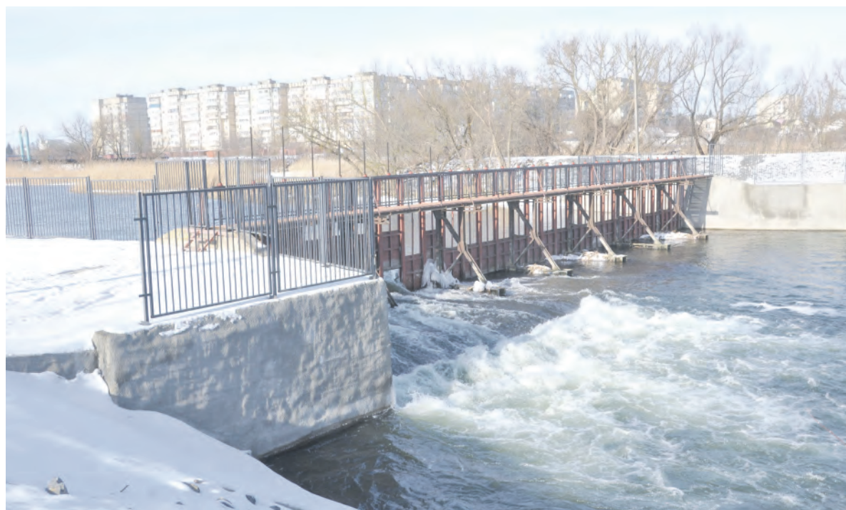
Плотина готова к весеннему паводку.
