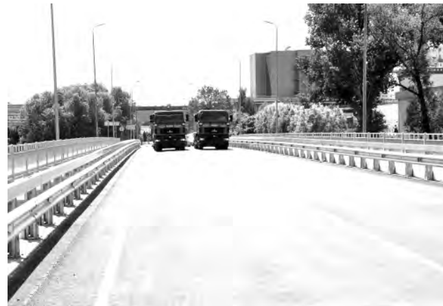
Капитально отремонтирован центральный мост — главная городская транспортная артерия.
