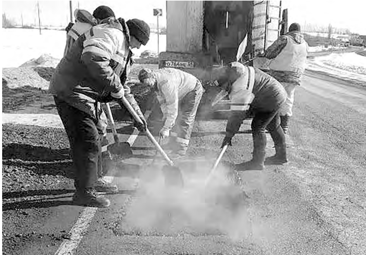
Ремонт дорожного полотна в Алексеевском округе.
