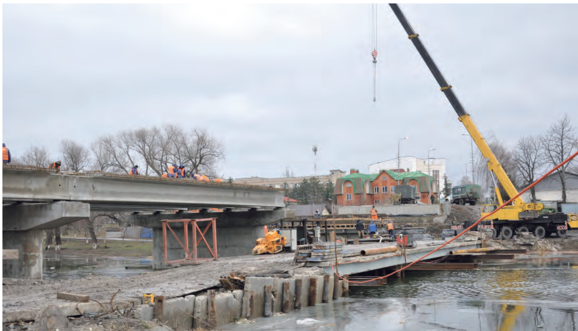
Временный технологический мост (на первом плане) будет убран перед сдачей моста в эксплуатацию.
