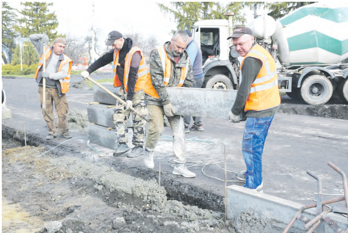
В ходе реконструкции дорожного участка Красное-Польниково строители устанавливают бордюры.
