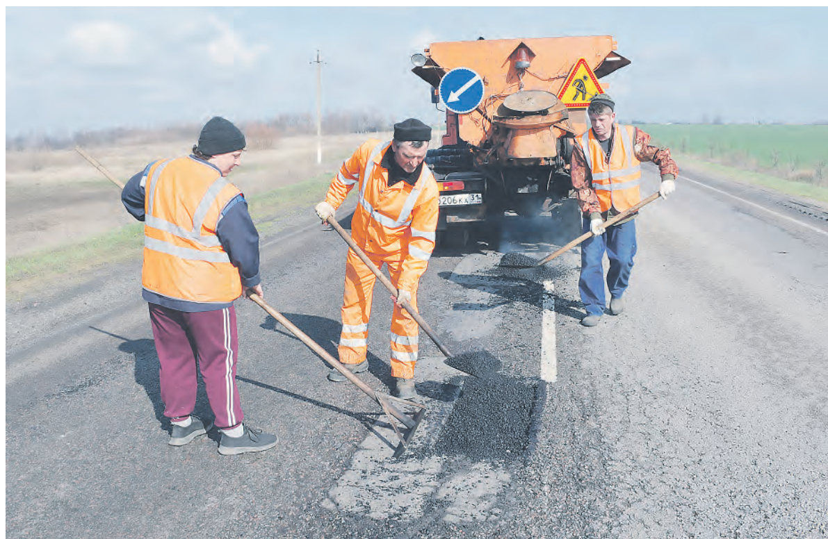
Бригада оперативно заделывает повреждения асфальтового покрытия.
