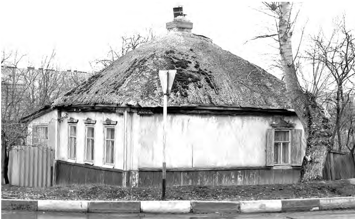
Место на пересечении улицы Красноармейская и переулочка Некрасова.
