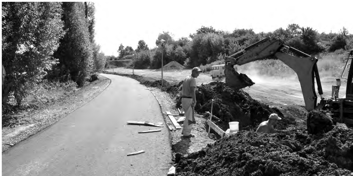
Водоотводные работы на участке дорожки, покрытой асфальтом.
