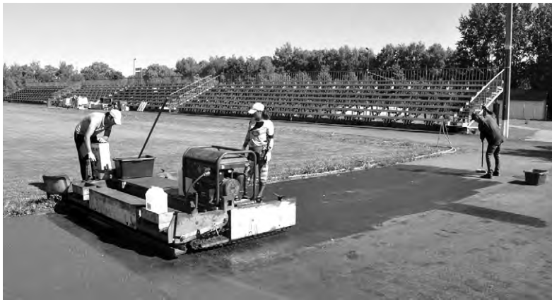
Агрегат укладывает резиновое покрытие.
