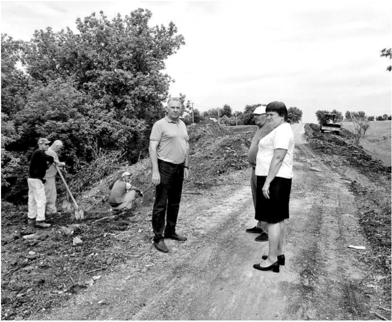
«Партийный десант» контролирует ход ремонтных работ в хуторе Папушин.
