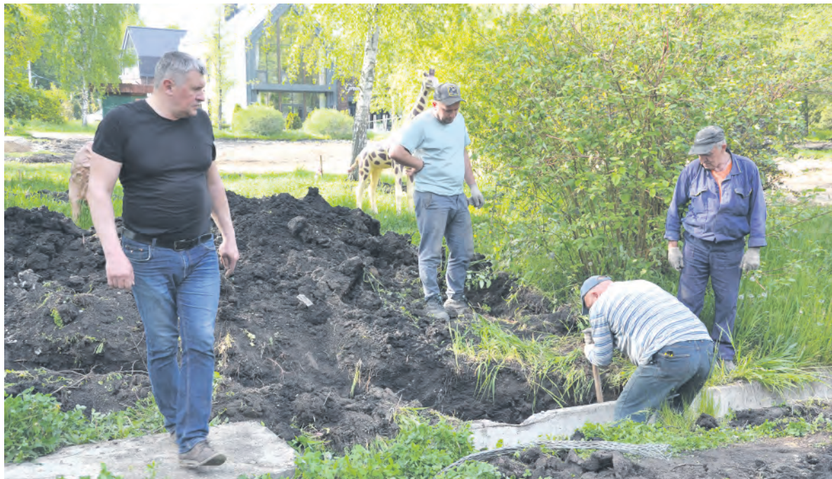
Первоочередные работы в процессе благоустройства территорий — прокладка подземных коммуникаций.
