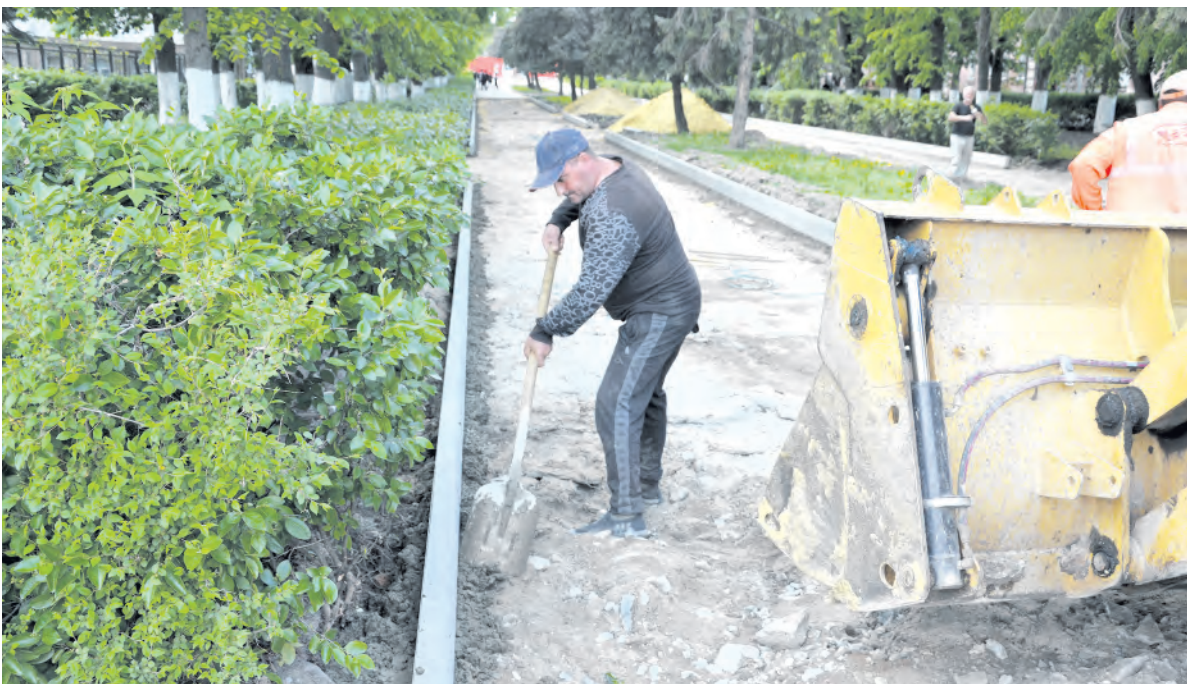
Рабочие устанавливают бордюры и готовят площадку для нового тротуарного покрытия в части сквера Гагарина, примыкающей к площади Никольской.
