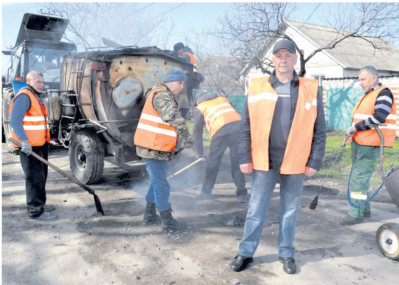
Специалисты бригады провели ямочный ремонт улицы П. Юценко под руководством начальника цеха по ремонту и содержанию дорог МБУ «Благоустройство» Виктора Селищева.
