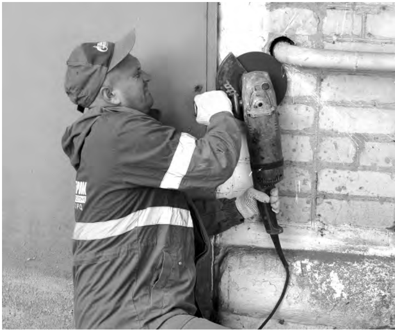
Идёт демонтаж газопроводных труб.
