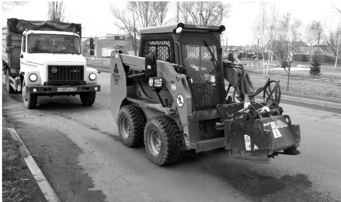
Трактор «Термит» с прицепной фрезой срезает участок асфальта для ремонта.
