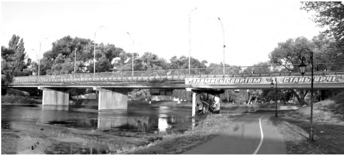
Центральный железобетонный мост. 2020 год.
