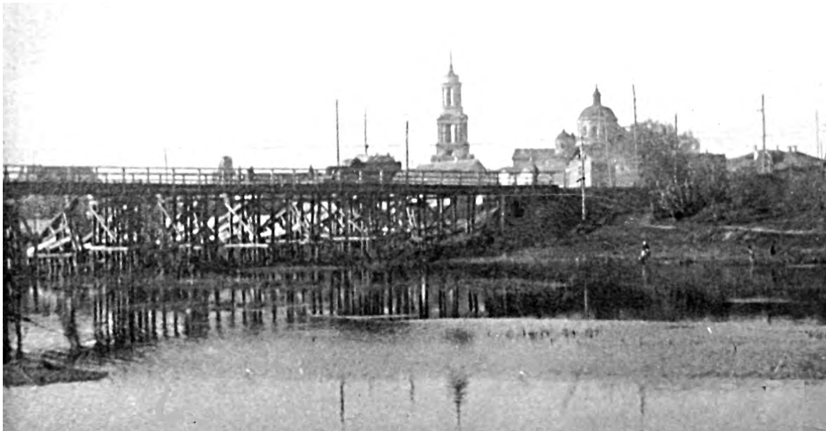
Центральный деревянный мост.
