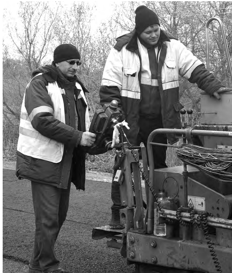
Хорошо настроенный асфальтоукладчик — залог качественной работы.
