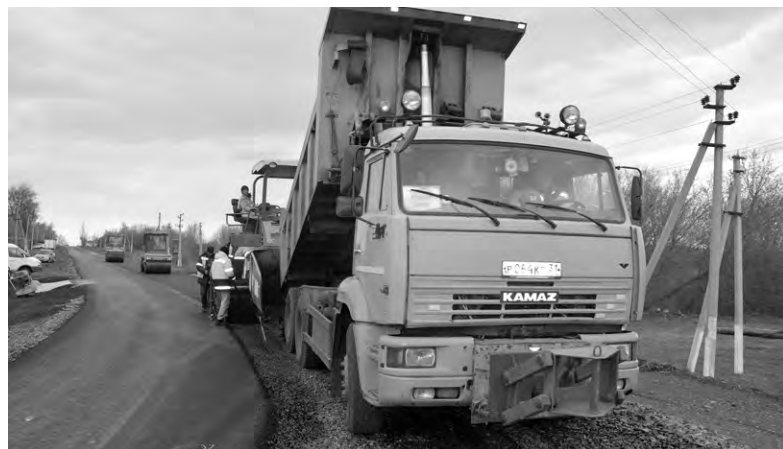
Дорожное полотно в Черёмухово рабочие «Мостдорстроя» уложили за считанные дни.
